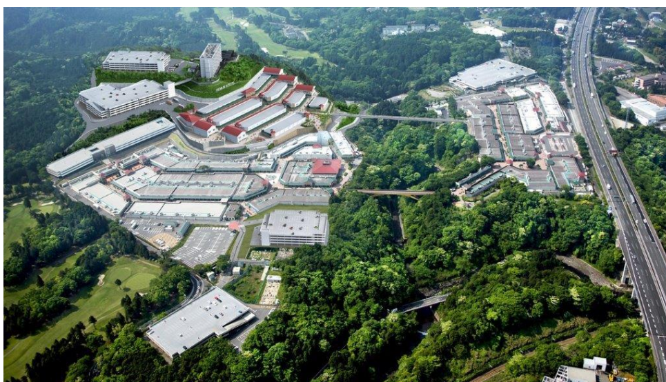
上部の赤い屋根の建物が2020年に増設される部分です。
