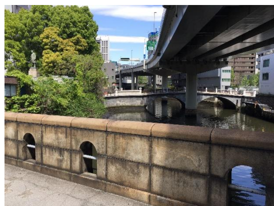
手前に鉄筋コンクリートの常盤橋 左上に渋沢栄一氏の銅像
